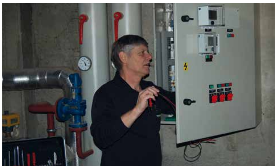
• Urs Gehrig beim Reglerumbau
