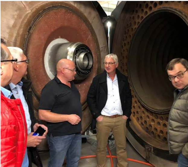
Einblick in Kessel mit neuem Brenner
