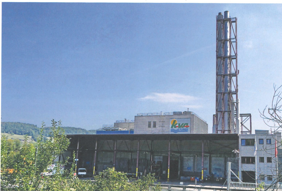
Hier erfolgt die Anlieferung des Heizmaterials (= des Kehrichts).
